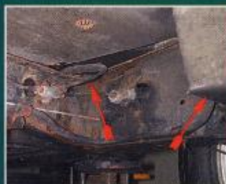
Hilfsrahmen und Batteriekasten (Pfeile) sind typische Rostherde
