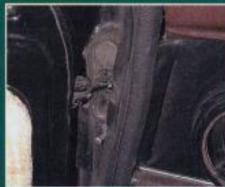
Inspizieren Sie die A-Säule in diesem Bereich und die Türen rundum
